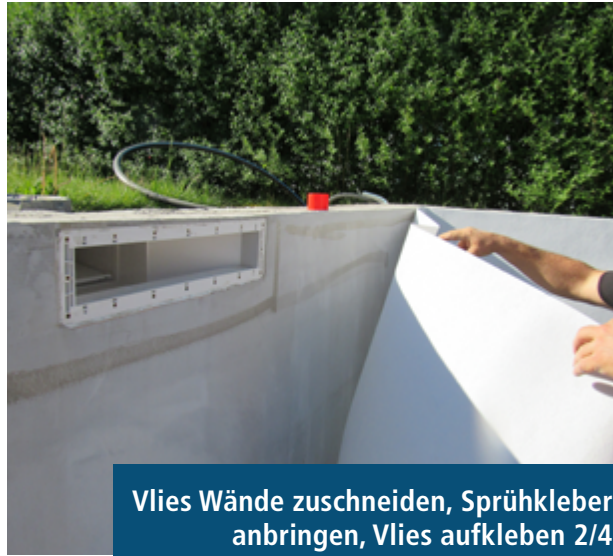
Vlies Wände zuschneiden, Sprühkleber anbringen, Vlies aufkleben 1/4
