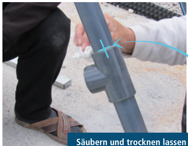
Mit professionellem Kleber und Reiniger arbeiten.
