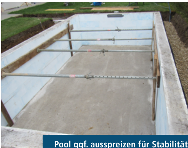
Schotter Hinterfüllung
