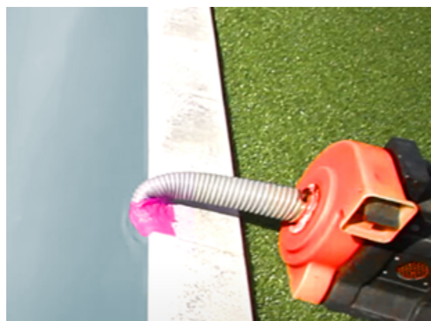
Vakuumsauger zwischen Treppe und Poolwand positionieren
