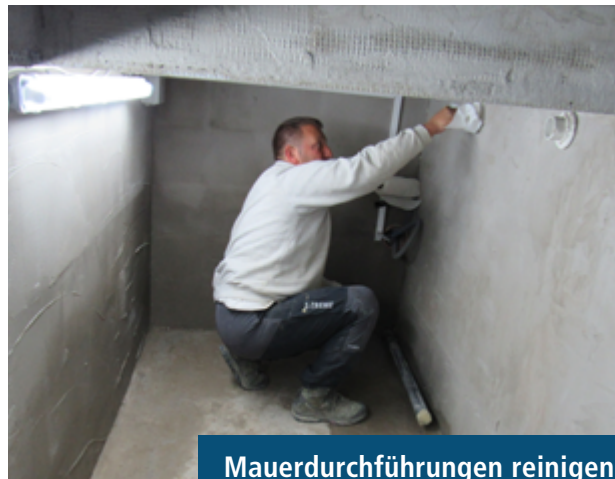
Fittings reinigen vor Ankleben an Mauerdurchführungen
