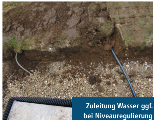
Schotter Hinterfüllung
