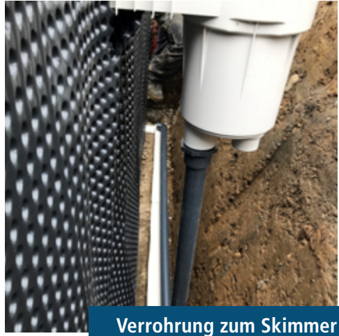
Noppenfolie an Außenseite und Verrohrung über Längsseite
