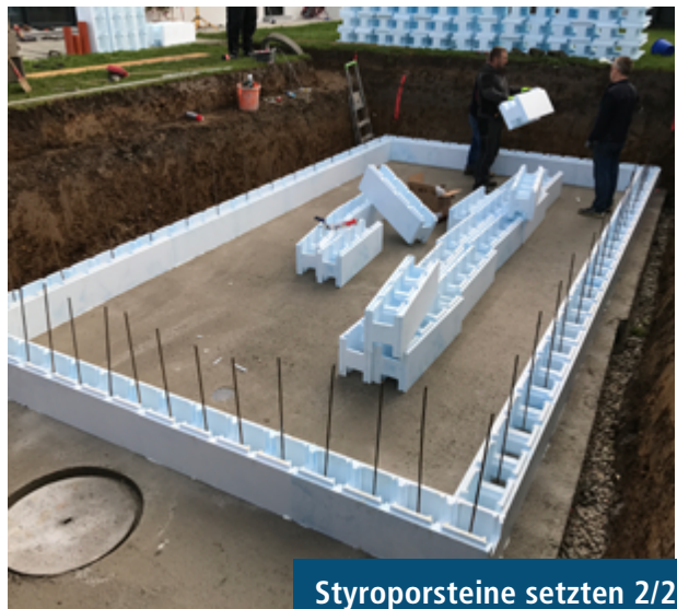
Senkrechte Eisenstäbe einsetzen 2/2
