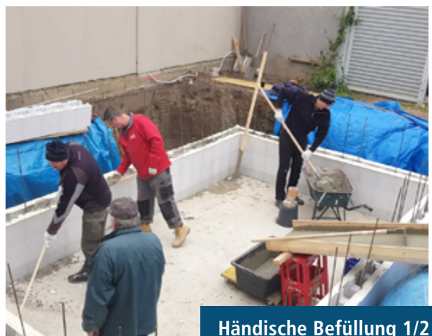
Styroporsteine langsam mit Beton befüllen 1/2
