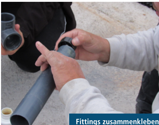
Kleber mit Pinsel auftragen
