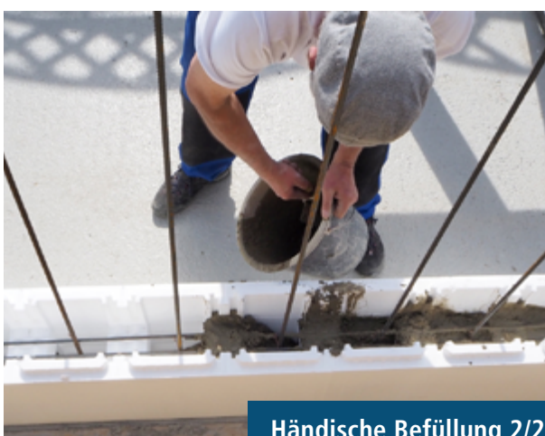
Styroporsteine langsam mit Beton befüllen 2/2
