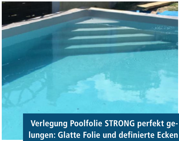
Befüllung beginnen und Beschwerung schrittweise entfernen
