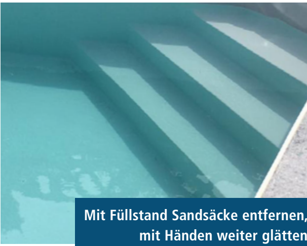
Nach Einrichten der Treppenfolie ausreichend beschweren
