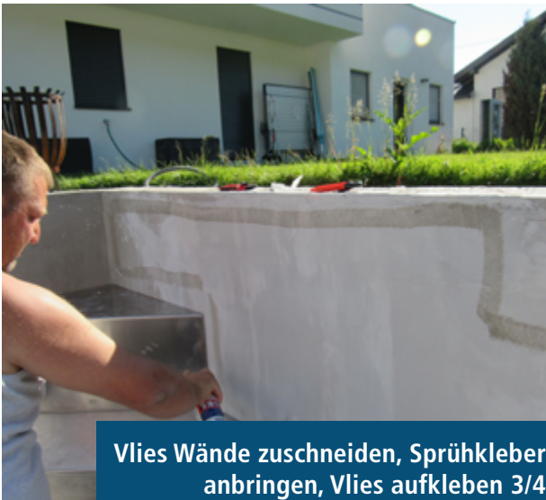
Vlies Wände zuschneiden, Sprühkleber anbringen, Vlies aufkleben 1/4
