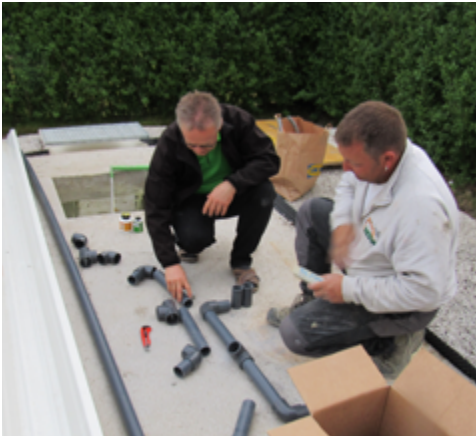
Verrohrung auflegen und sortieren
