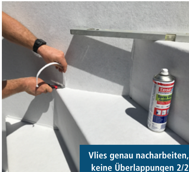
Vlies genau nacharbeiten, keine Überlappungen 1/2
