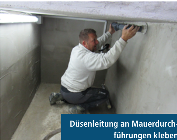
Fittings reinigen vor Ankleben an Mauerdurchführungen
