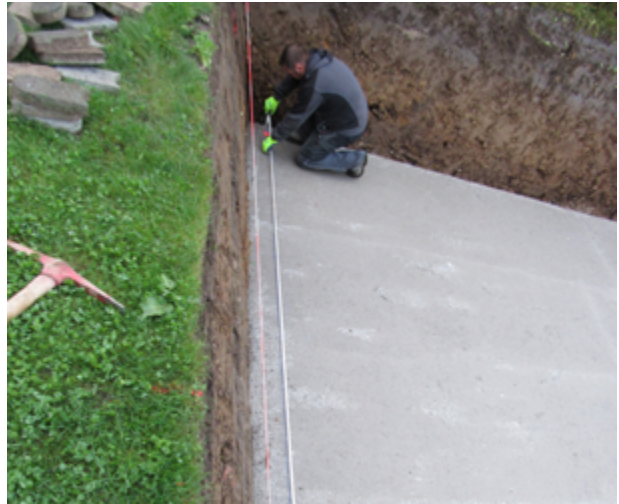
Poolstruktur für Armierungen anzeichnen 1/2
