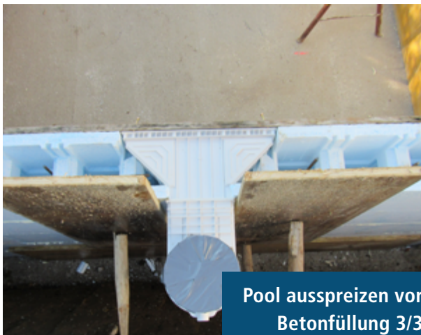
Pool ausspreizen vor Betonfüllung 1/3
