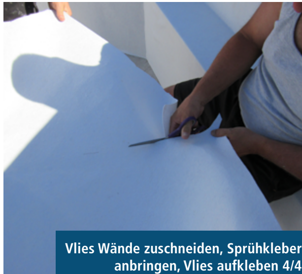
Vlies Wände zuschneiden, Sprühkleber anbringen, Vlies aufkleben 2/4
