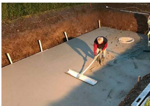
2. Bodenplatte betonieren
