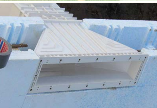
4. Einbauteile ausschneiden und montieren
