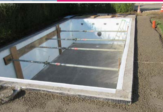
7. Rundum verrohren, Schotter & Betonkranz
