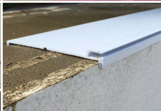
6. Klemmprofileiste in noch feuchten Beton drücken
