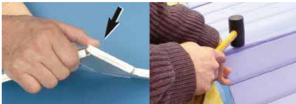
Abbildung 44 – Einklemmen der Lamellen
