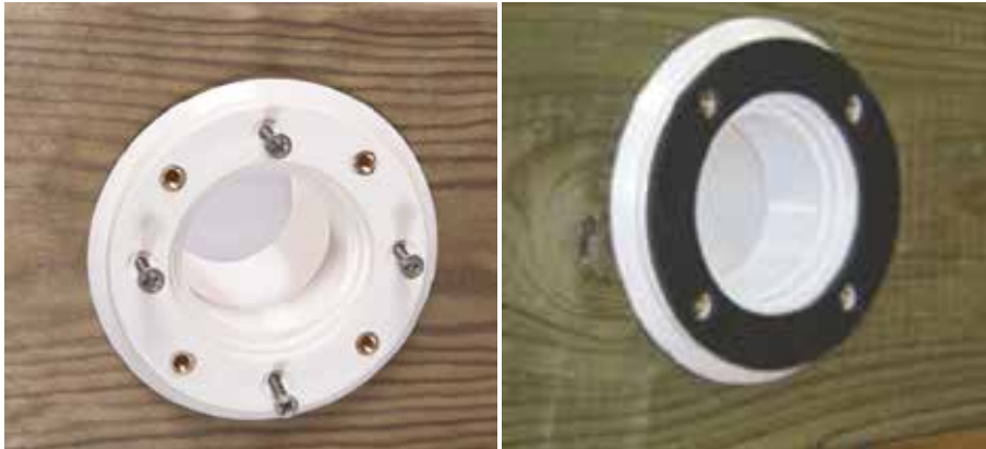
Abbildung 24 – Montage der Ausstoßdüse und seiner Dichtung
