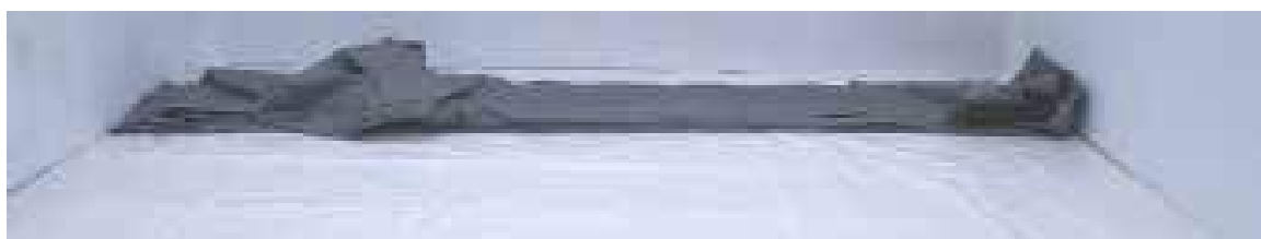
Abbildung 32 – Entfalten der Folienauskleidung
