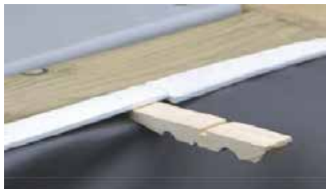
Abbildung 31 – Verkeilung der Folienauskleidung mithilfe der halben Wäscheklammern
