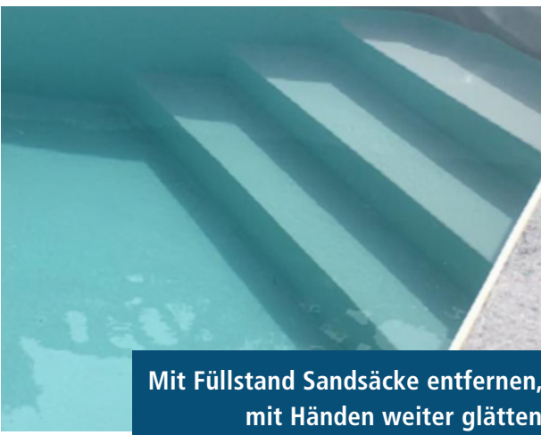
Nach Einrichten der Treppenfolie ausreichend beschweren
