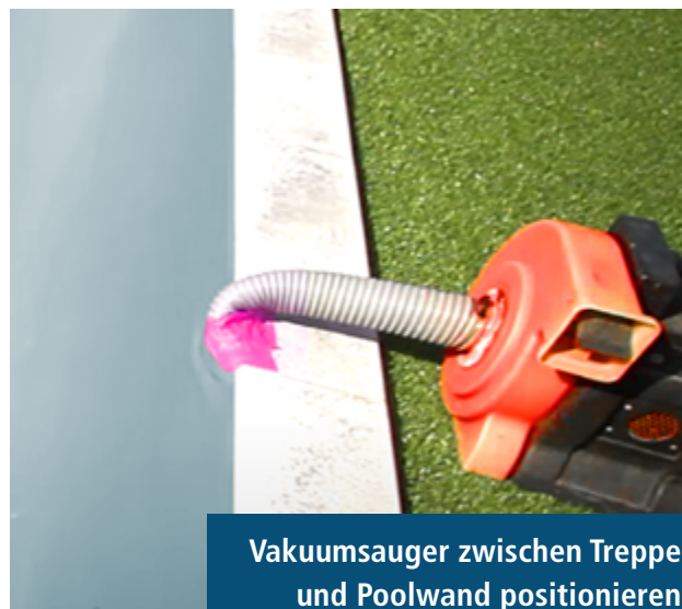
Ein Vakuumsauger kann das Verlegen deutlich erleichtern
