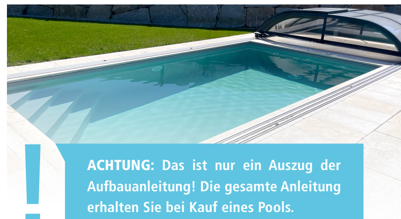
Sitzbank, Treppe & Boden beschweren, danach mit Wasser befüllen
