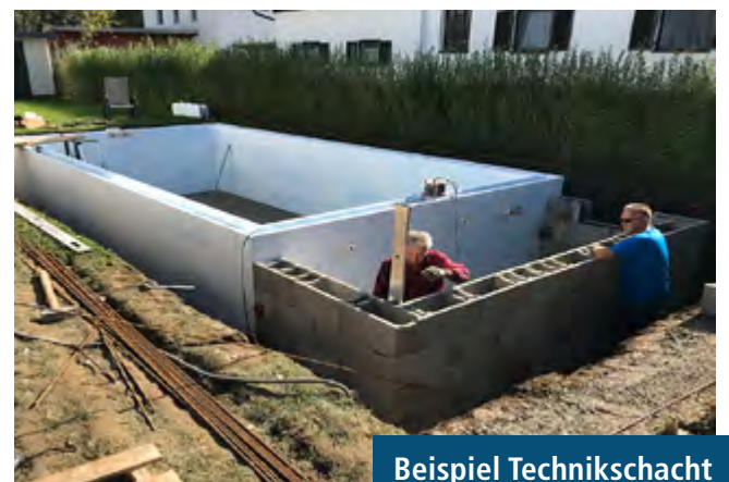
Styroporsteine setzen
