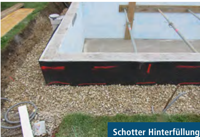
Styroporsteine langsam mit Beton befüllen
