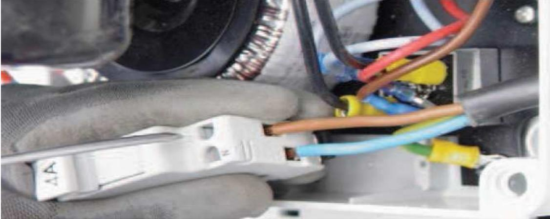
Der Erdleiter muss mit der Metallplatte verbunden werden, indem Sie den gelben Ringkabelschuh benutzen (vormontiert auf dem eingezogenen Tiefenerder). Pressen Sie mithilfe einer geeigneten Zange den Ringkabelschuh auf das Kupfer am Ende des Erdleiters. Anschließend schließen Sie die Öse des Ringkabelschuhs am Erdleiter an indem Sie ihn mit der Mutter festziehen.
